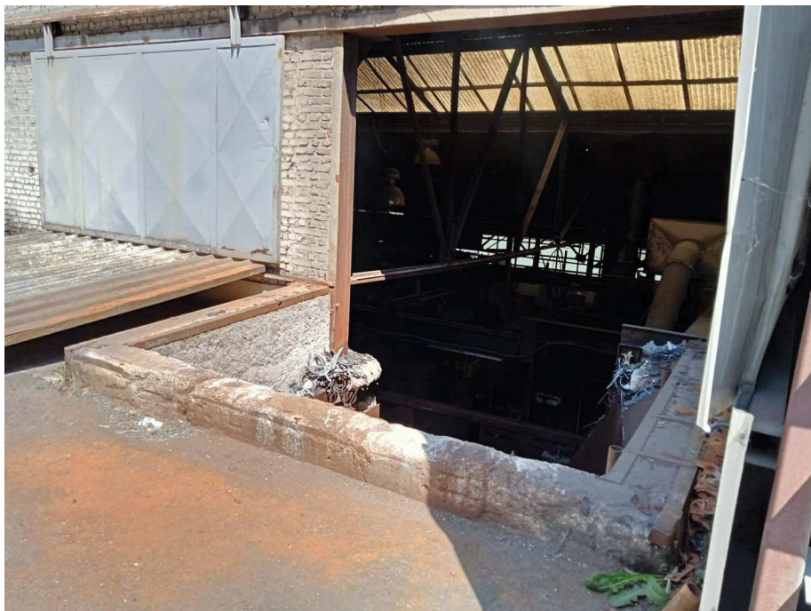
Zone de stockage des matières premières, située en contrebas de la route libre d'accès
