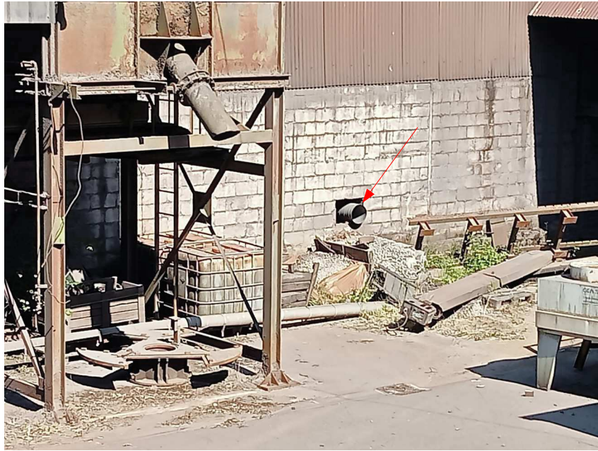
L'un des points de rejet des émissions des grenailleuses
