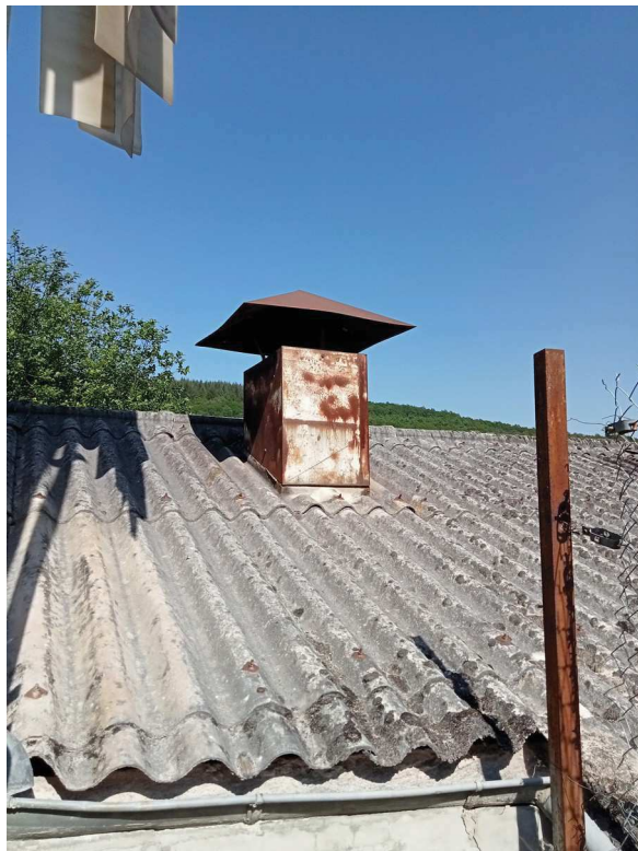
Chapeau-chinois présent sur le débouché d'une cheminée associée à l'activité de noyautage
