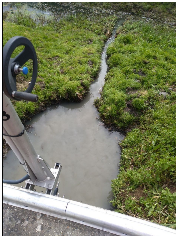
Aperçu du fossé situé au sud des entrepôts 2 et 3 après nettoyage
