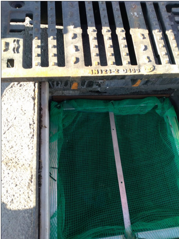
Exemple de panier filtrant mis en place sur un regard de collecte des effluents
