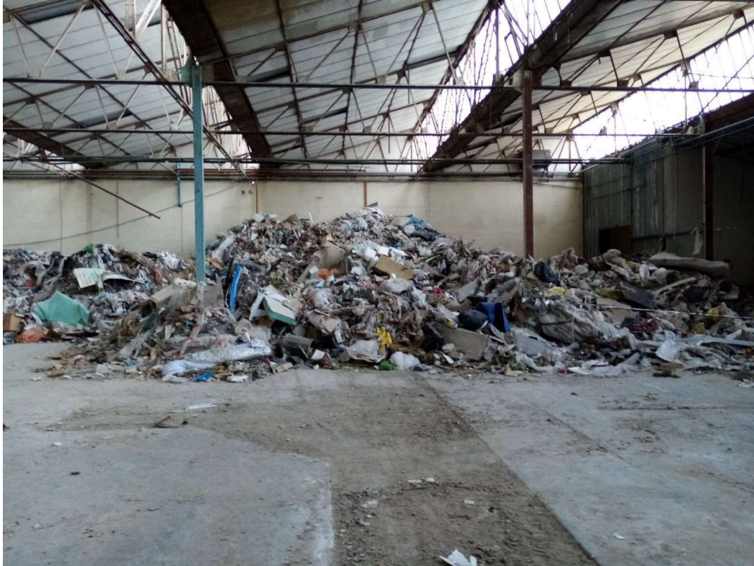
Intérieur du hangar le 28 mars 2022
