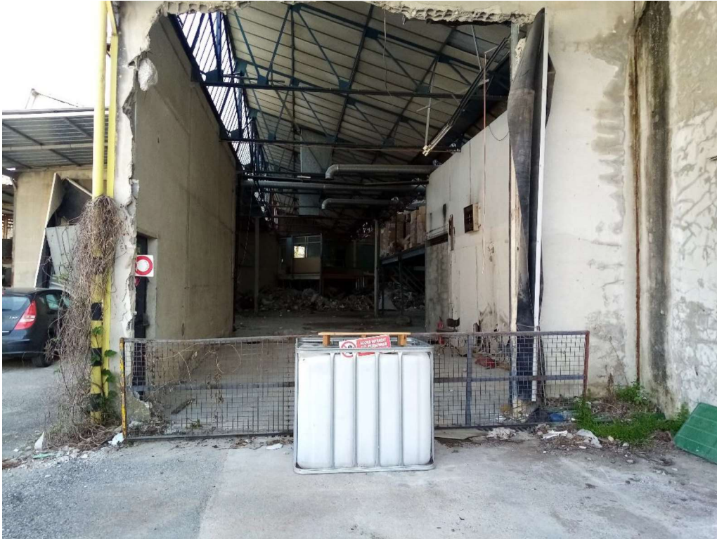
Ouverture dans le mur le 28 mars 2022
