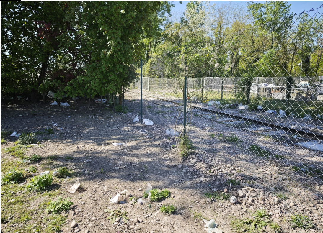
Clôture ouest dégradée et déchets au sein de l'exploitation et sur la parcelle voisine (dont sur la voie ferrée)
