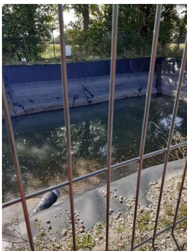
Bac d'immersion utilisé pour confiner et immerger la batterie en feu
