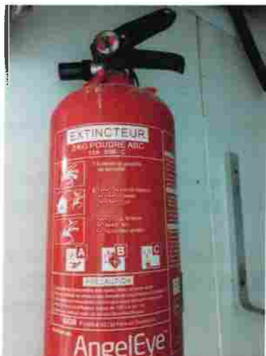
Extincteur à poudre avec indicateur de pression correcte
