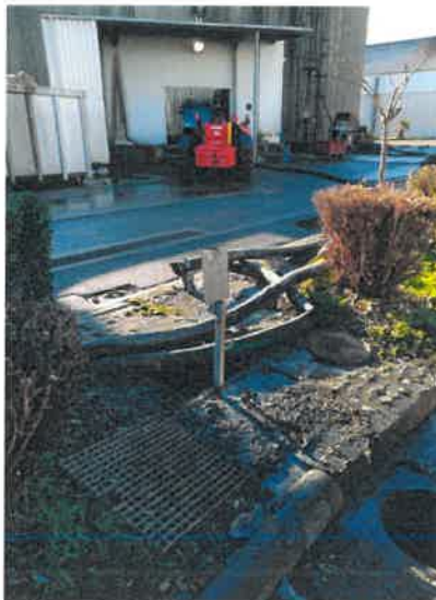
Regard eaux pluviales de voiries qui a été bouché et dans lequel a été placée la pompe pour transférer le digestat déversé sur les voiries vers la cuve d'acidification et vers le bassin de rétention
