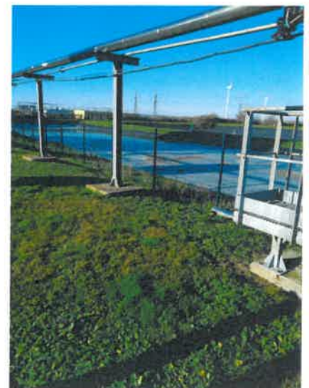
Bassin eaux pluviales (réaffecté en bassin de rétention lors de l'incident)
