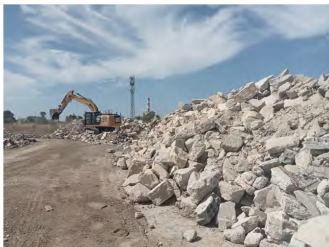
Déchets de béton
