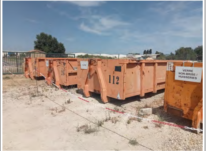
Bennes de collecte présentes à l'entrée du site, en attente pour une mise en œuvre prochaine
