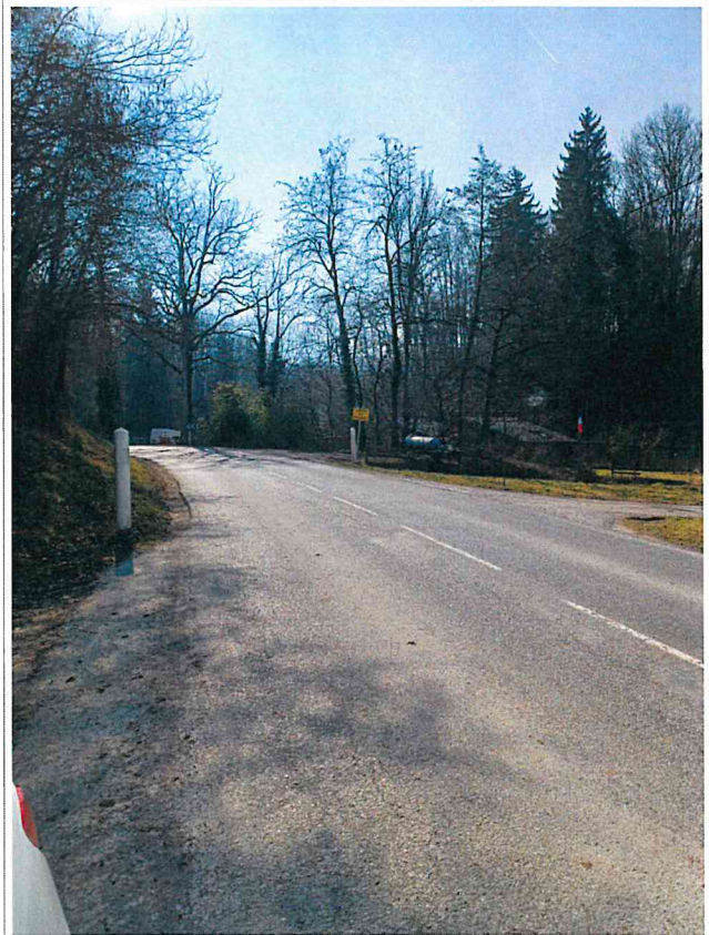
Photo n° 1 bis : Chantier aux Blaves
