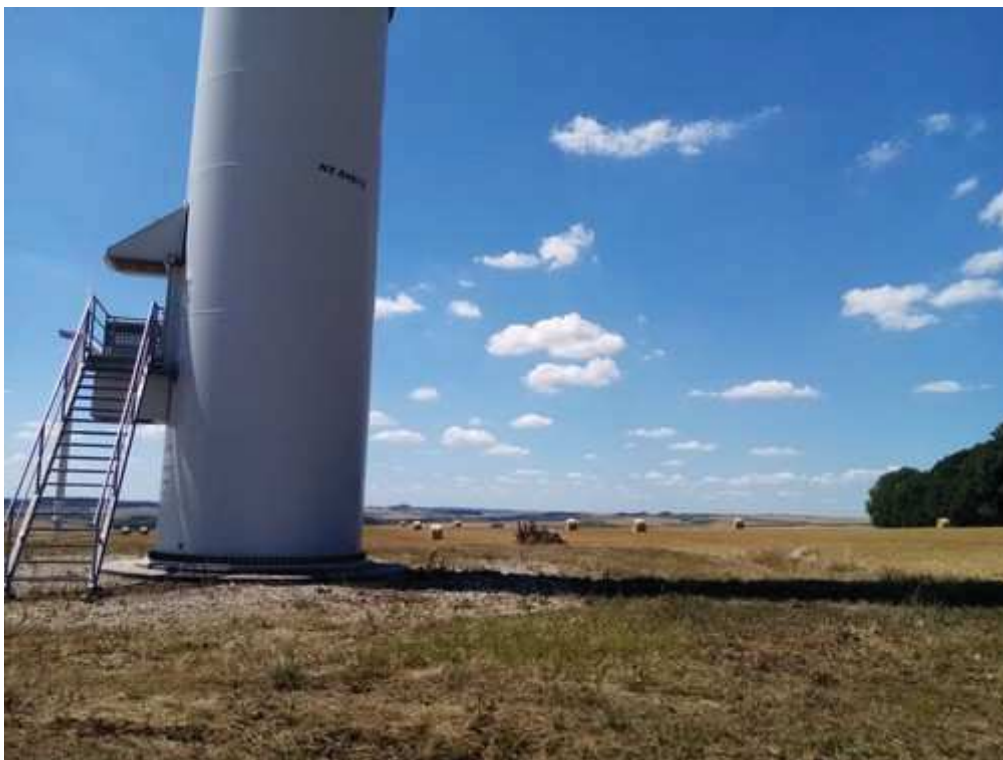
Photographie 1 : éolienne E7 (n°NX 84872) du parc éolien de Zondrange et sa parcelle n°404 (exploitant EAURL YRWELING) présentant des balles de paille non enlevées (cliché de l'inspection du 05/07/2022 à 12h30)
