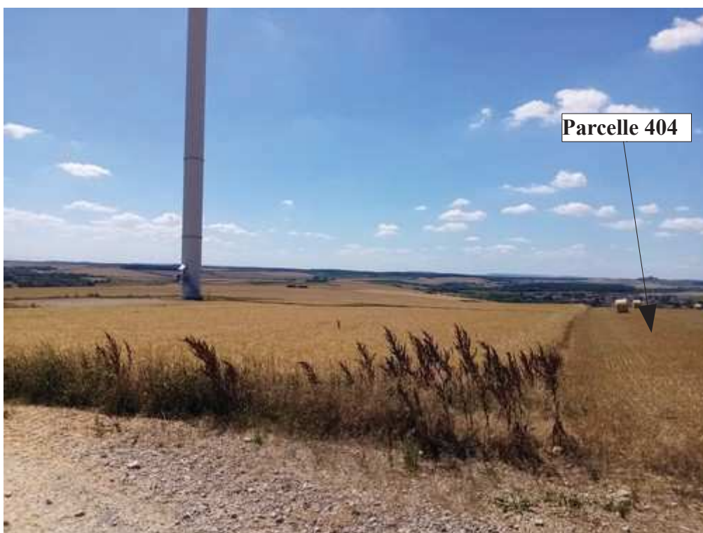
Photographie 2 : éolienne E6 (n°NX 84871) du parc éolien de Zondrange et sa parcelle n°404 (exploitant EAURL YRWELING) présentant des balles de paille non enlevées (cliché de l'inspection du 05/07/2022 à 12h33)
