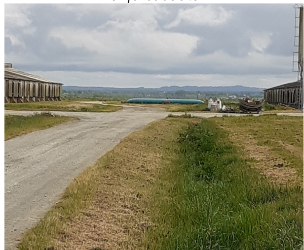
Réserve interne d'eau d'extinction d'incendie en fonds de site
