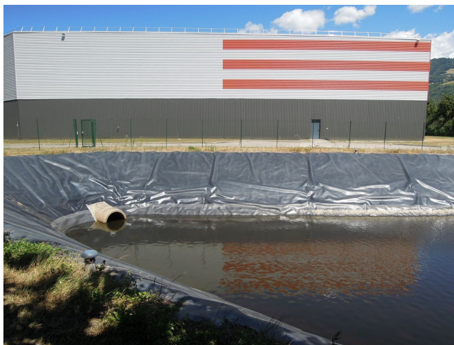
Bassin de rétention des eaux d'extinction d'incendie partiellement plein
