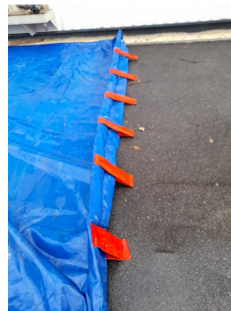
Déploiement de la bâche - zone extérieure de chargement
