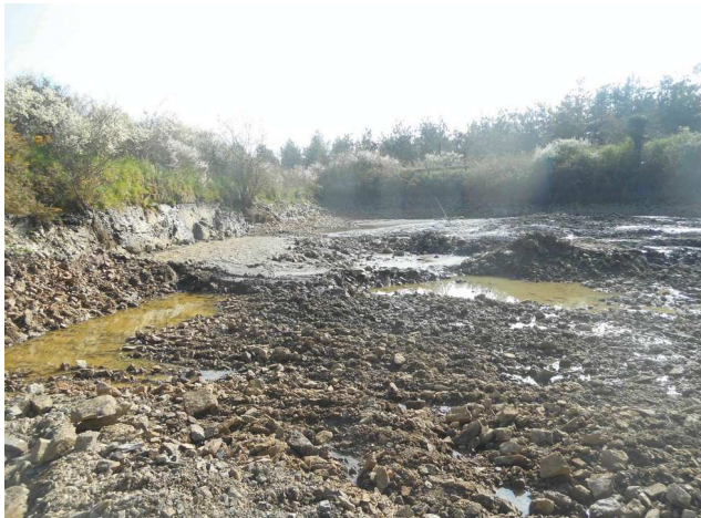
Excavation, secteur nord-est (fond du plan d'eau d'origine en arrière plan)
