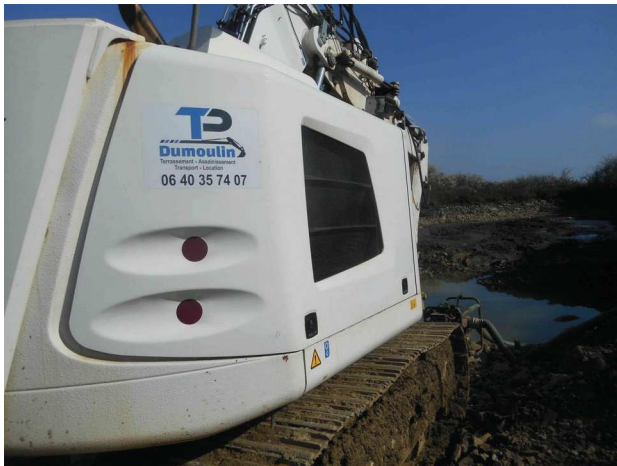
Engin et pompe de la société Dumoulin TP, présents dans l'excavation
