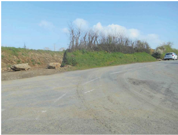
Accès à l'excavation vue depuis la jonction de la route du Lys et de la RD84 (au sud)
