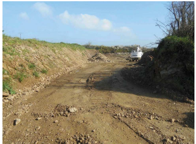
Excavation vue depuis le sud
