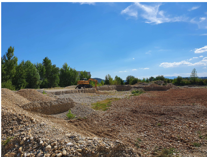
Photos 7 et 8 – Fosse qui semble en cours de remblayage : des traces de pelle sont visibles (pelle présente en arrière-plan).
