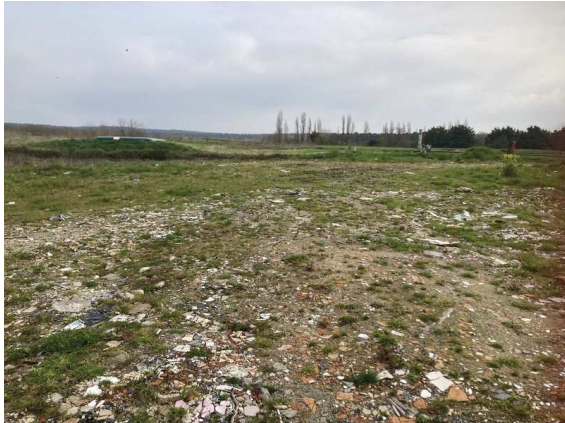
Absence de couverture sur le dernier casier fini d'exploité le 06/06/2023
