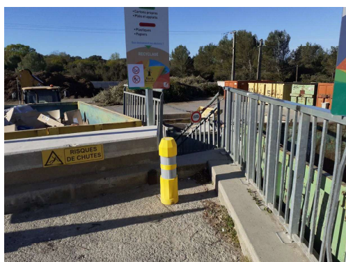
Risques de chutes et interdiction d'accès escalier de service
