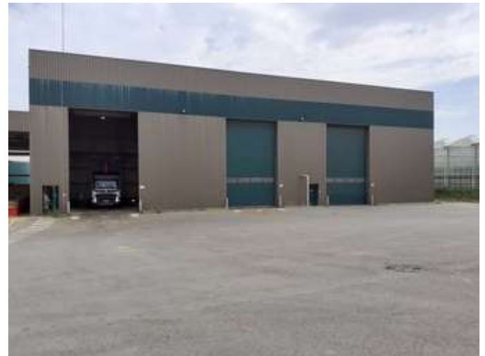
Bâtiment de prétraitement
