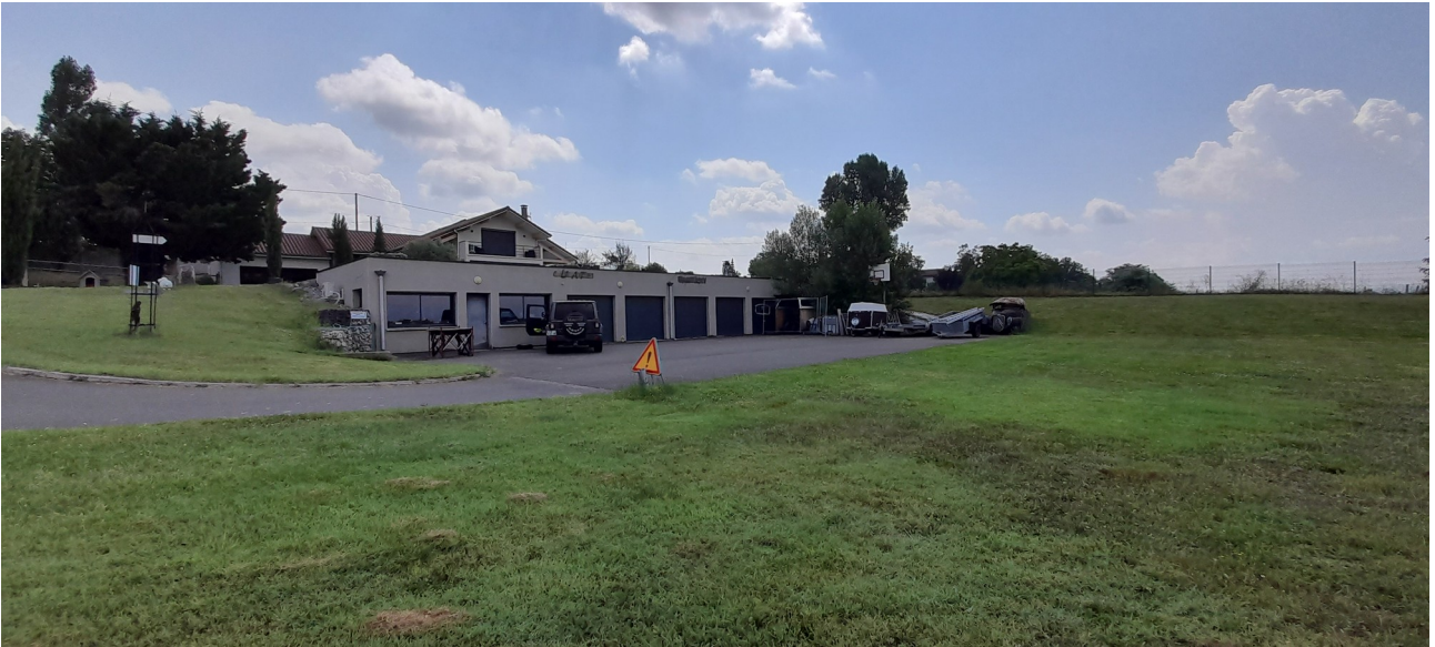
Figure 1: 01/08/2024 - Construction d'un garage et d'une habitation dans l'emprise de l'ex-ISDI - Permis de construire PC04232315A0014 du 23 juillet 2015 accordé par la commune de Veauche
