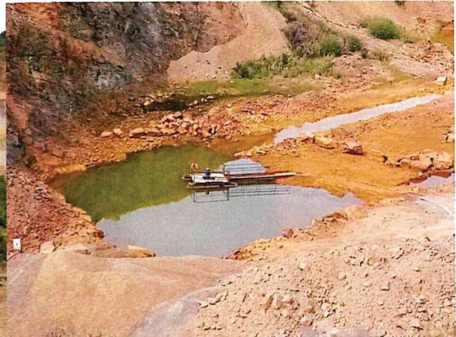
Photo 4 : Dispositif de pompage de l'eau en fond de carrière
