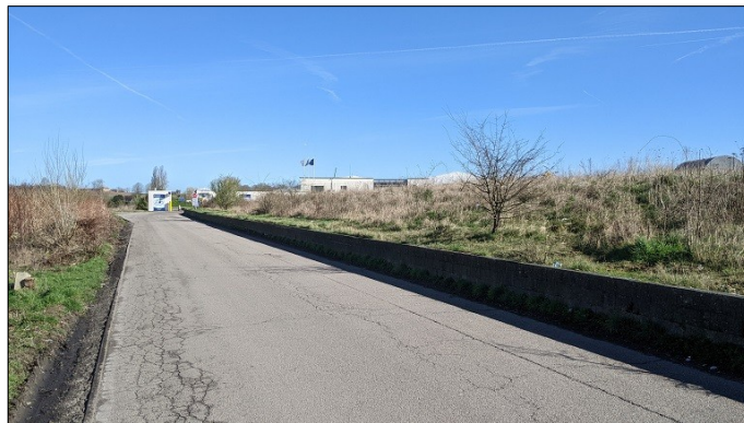
Muret le long du site et site PAPREC mitoyen
