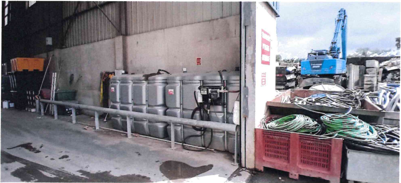
Entreposage de déchets de plastique accolés au bâtiment de tri accolé au mur derrière lequel se trouve un réservoir de carburant (GNR)
