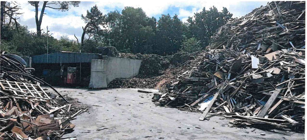
Entreposage de déchets de bois à proximité du bâtiment contenant un réservoir de carburant (GNR)
