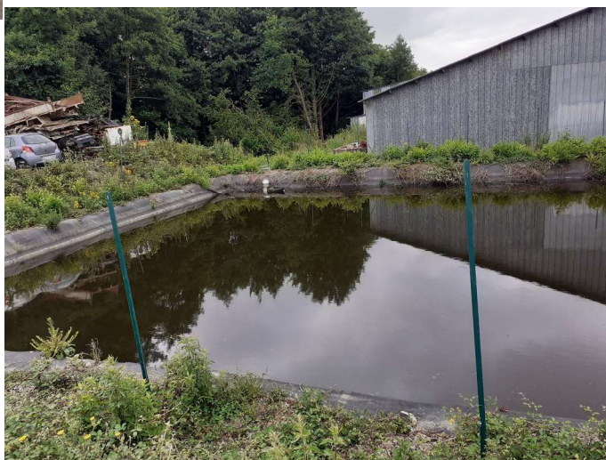
Vue sur le bassin tampon (doté d'une membrane imperméable) réceptionnant les eaux résidaires après passage dans un séparateur hydrocarbure
