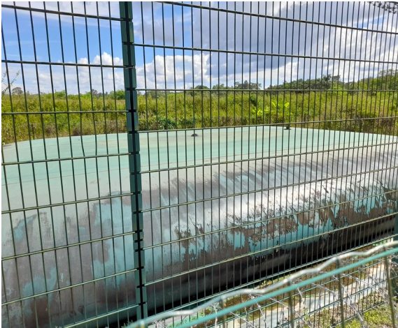
Bâche incendie en entrée de site
