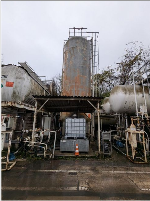
Figure 1: Vue d'ensemble du réservoir R109
