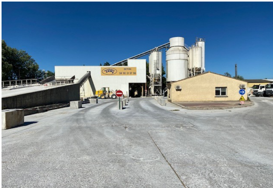
Photo n°4 – vue des silos de la centrale à béton
