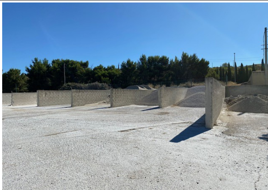
Photo n°2 – stockage des matériaux à l'air libre à proximité immédiate du chemin de Bompas sis Vedène
