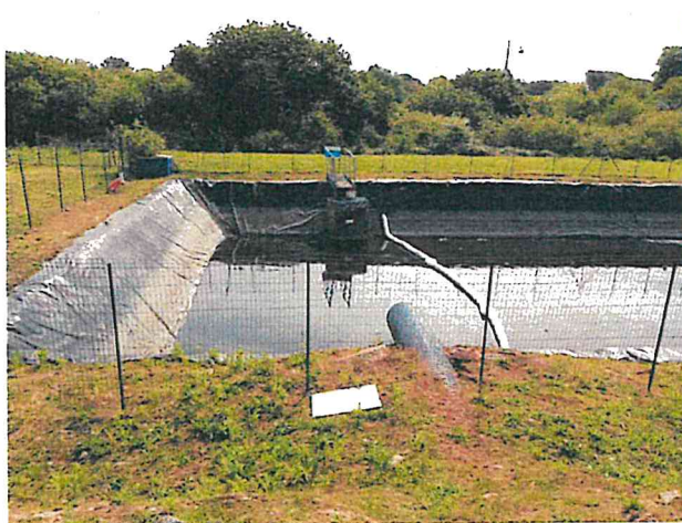
Photo 1 : Bassin ouest du site montrant au second plan le poste d'actionnement de la vanne d'isolement
