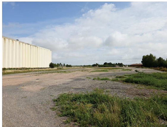
Entrée sud-ouest - Plateforme inoccupée
