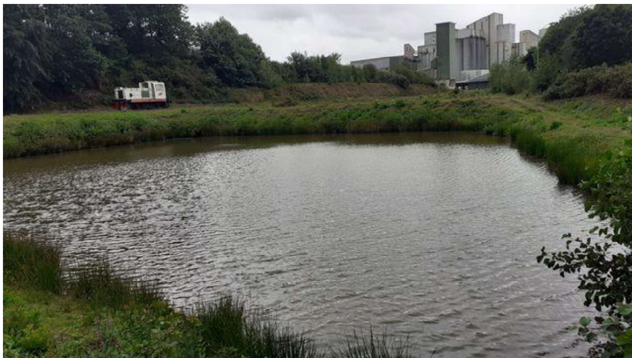
Bassin de décantation du site
