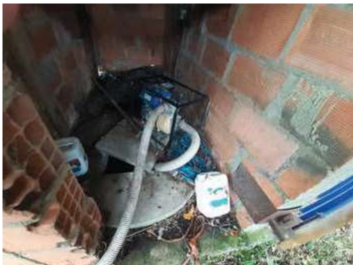
Intérieur du local proche de l'étang
