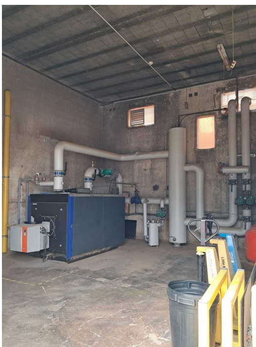
Nouvelle chaudière gaz dans l'ancienne chaufferie (plus de chaudière biomasse)
