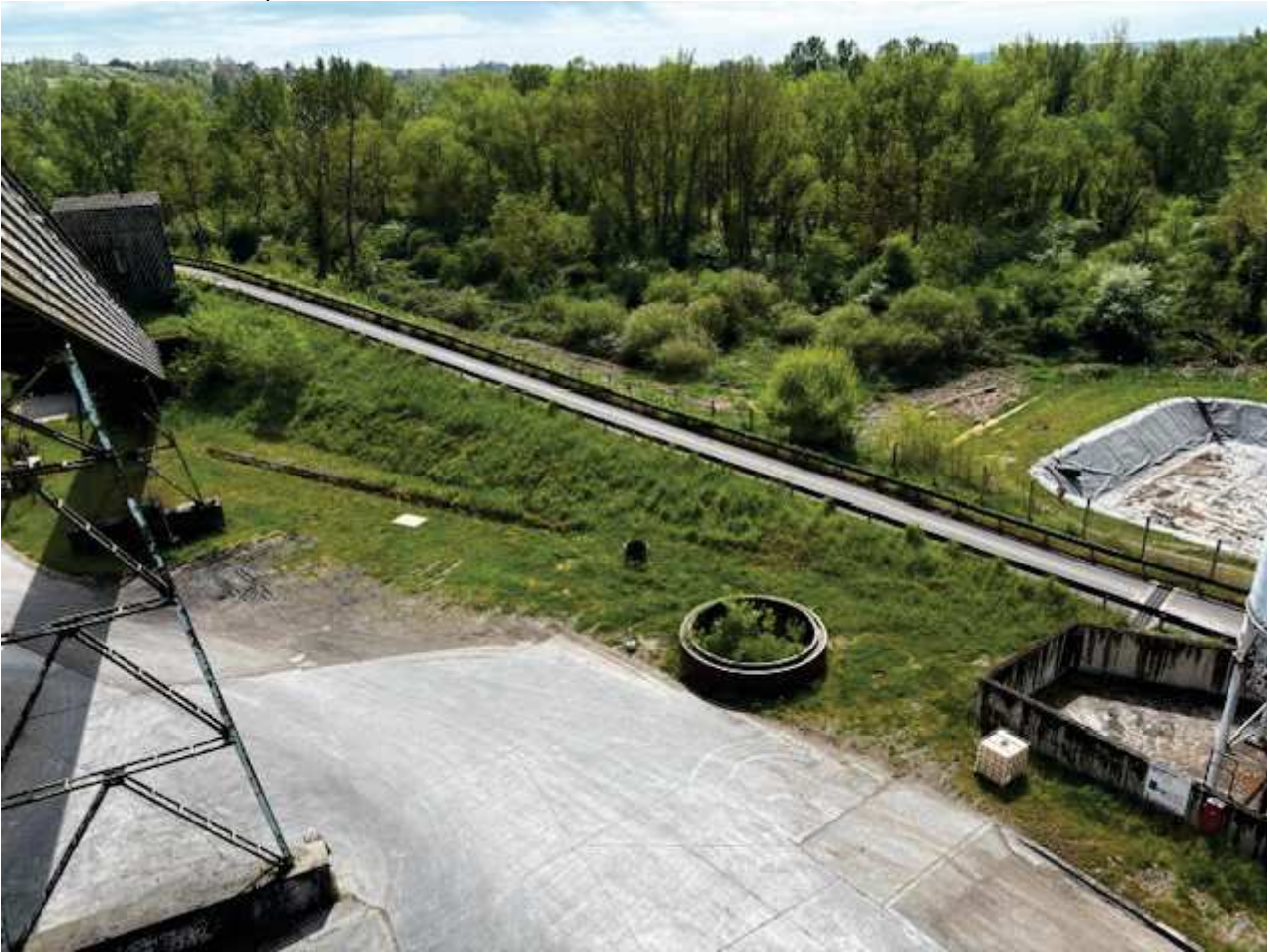
Aménagements permettant de récupérer les fines de charbon autour de la trémie de chargement
