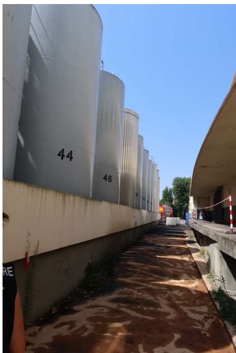
Mise en place du produit absorbant (photo LCPP)
