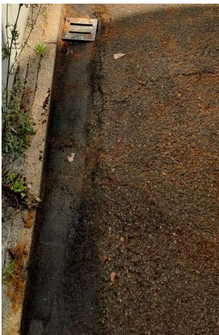
Bouche d'évacuation des eaux pluviales (photo inspection)
