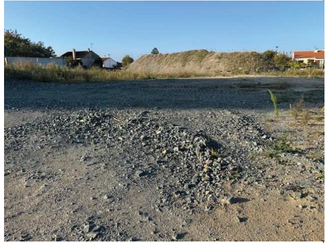
Vue sur le terrassement de la parcelle 248
