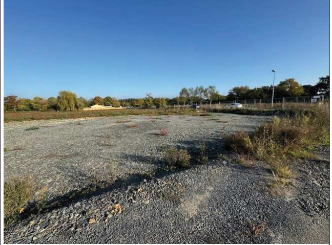
Vue sur les parcelles 262 et 392 et sur le terrassement en premier plan de la parcelle 262
