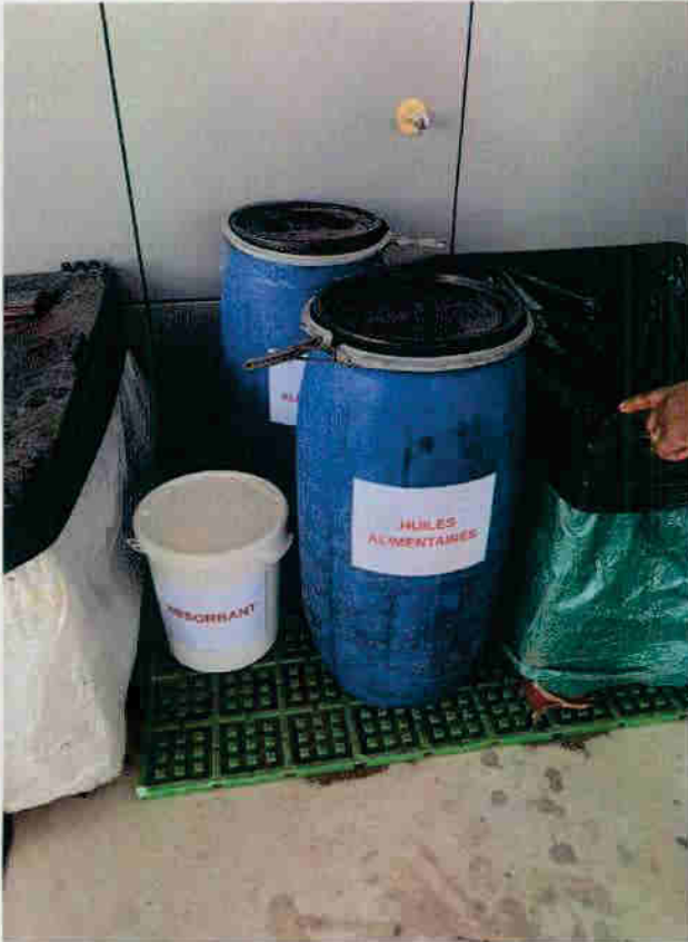
Rétention insuffisante (volume estimé à environ 3 litres) sous les deux fûts des huiles ménagères (2 fois 120 litres)
