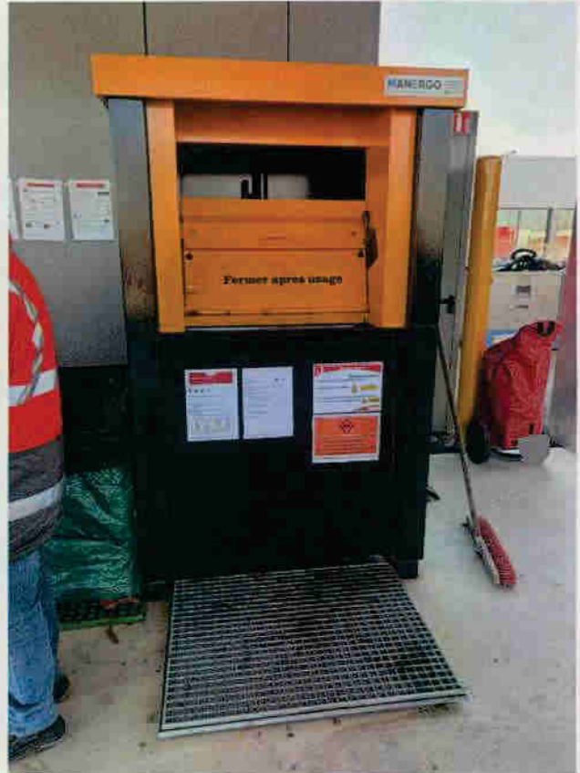
Absence de cuvette de rétention étanche sous la borne à huile
