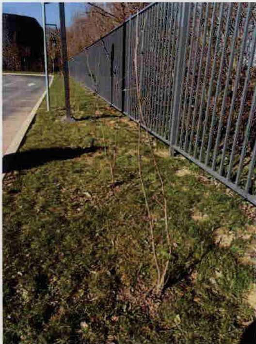
Clôtures perméables à la circulation des amphibiens, reptiles et mammifères terrestres
