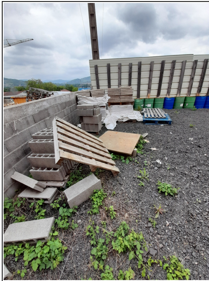
Photo n°3 : Matériaux de bâtiment entreposés
