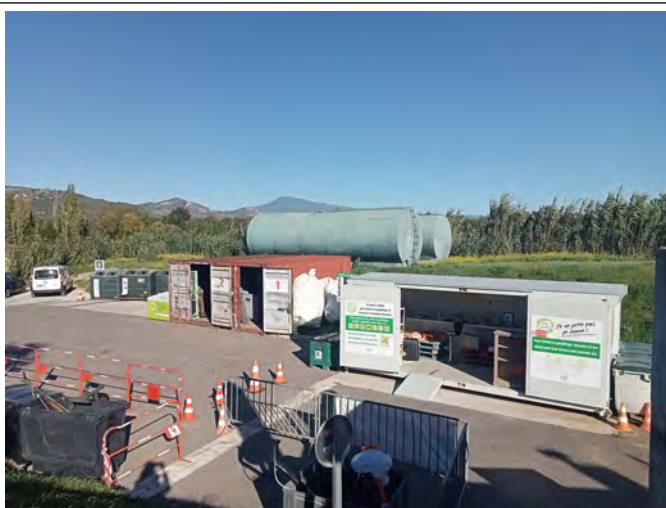
Deux citernes réserve d'eau incendie
