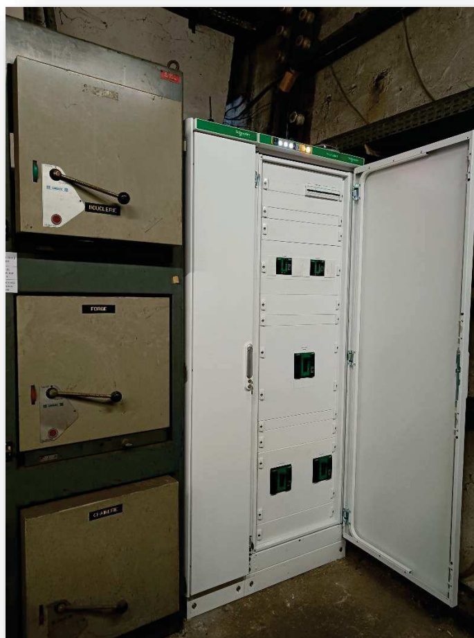
Figure 4 : Guirlande électrique neuve
