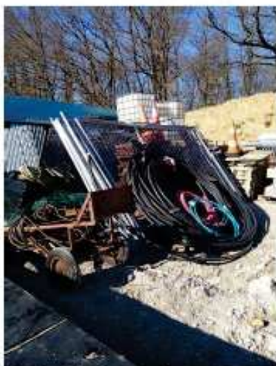
Matériel de chantier subsistant sur site
