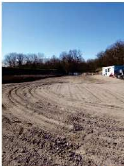
Vue depuis le milieu du site. Il ne subsiste que le bungalow, présent à l'origine de l'activité d'EDTP et AMIANTECO, ainsi que du matériel de chantier d'AMIANTECO
