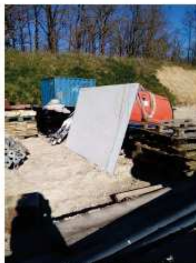
Même zone : matériel de chantier subsistant sur site
