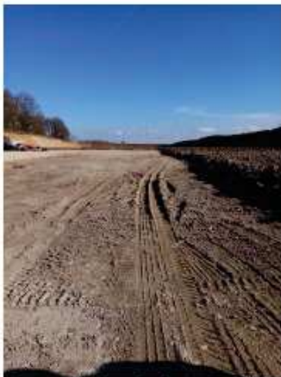
Les déchets ont été évacués du site. Les zones où les camions n'ont pas besoin de circuler ont été hersées. Les merlons ont été remis en forme.
