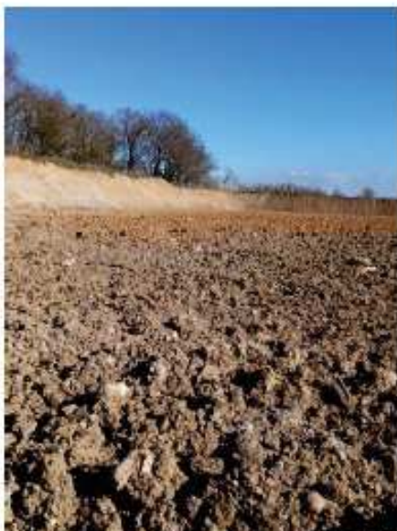
Fond du site : partie également où est passée la herse + vue sur les merlons remis en forme. Ancienne zone où se trouvaient les déchets en mélanges et les déchets de béton, démolition et broyats
