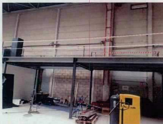
Figure 1: Mezzanine en construction (à droite de l'entrée cellule hall B)
