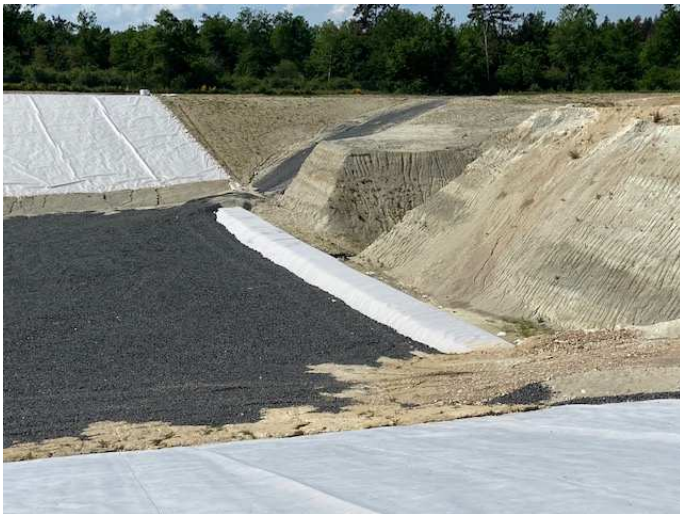
Diguette de séparation aval du casier 3.3
