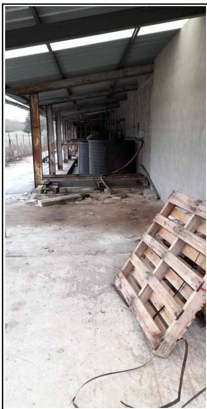
Photo N°7 : Vue du auvent coté sud
