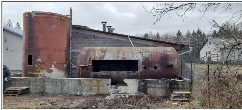
Photo N°6 : Vue des cuves coté sud-ouest
