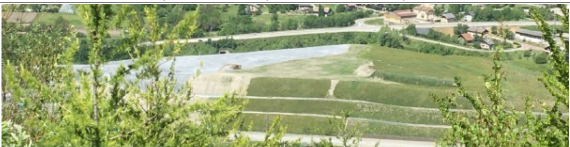
Façade sud (vue septembre 2021) du dépôt
