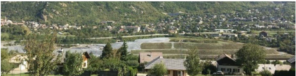
Façade sud (vue septembre 2020) du dépôt
