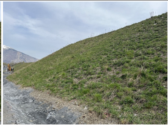
Façade sud (secteur 2019) du dépôt
