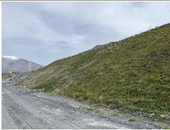
Façade sud (secteur 2021) du dépôt
