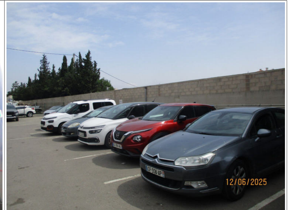
4 rangées de parpaings ajoutées à la clôture de l'établissement
