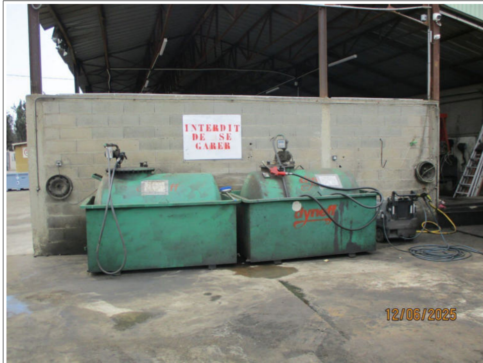
Stockage des gazoles utilisés pour le ravitaillement des véhicules et engins de chantier évoluant dans l'établissement
