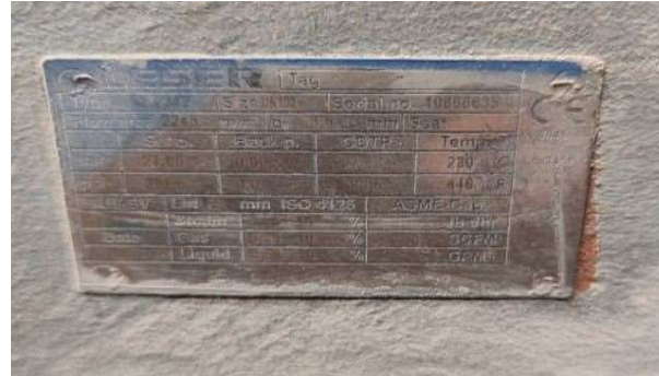
Plaque signalétique d'une soupape à 27 bars
