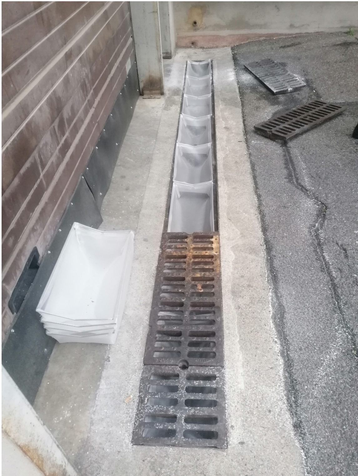
Figure 1: Dispositifs de confinement et de récupération des granulés de plastiques industriels
