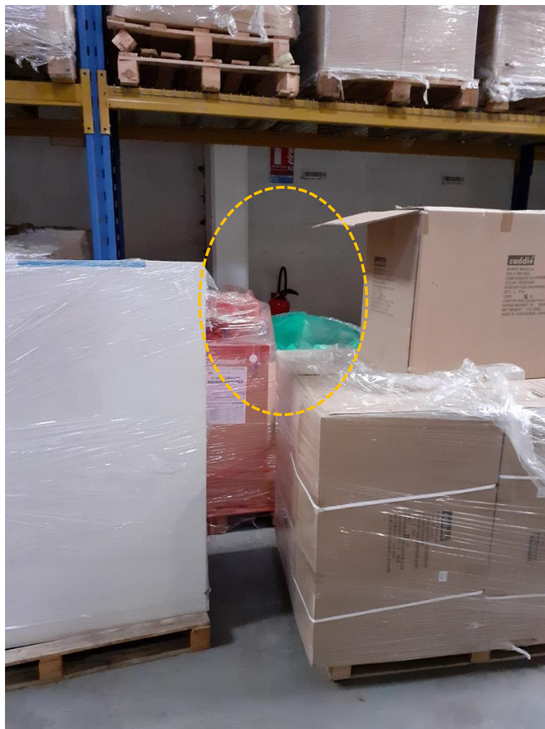
Figure 8 : Extincteur situé dans la cellule 2 du bâtiment 2
