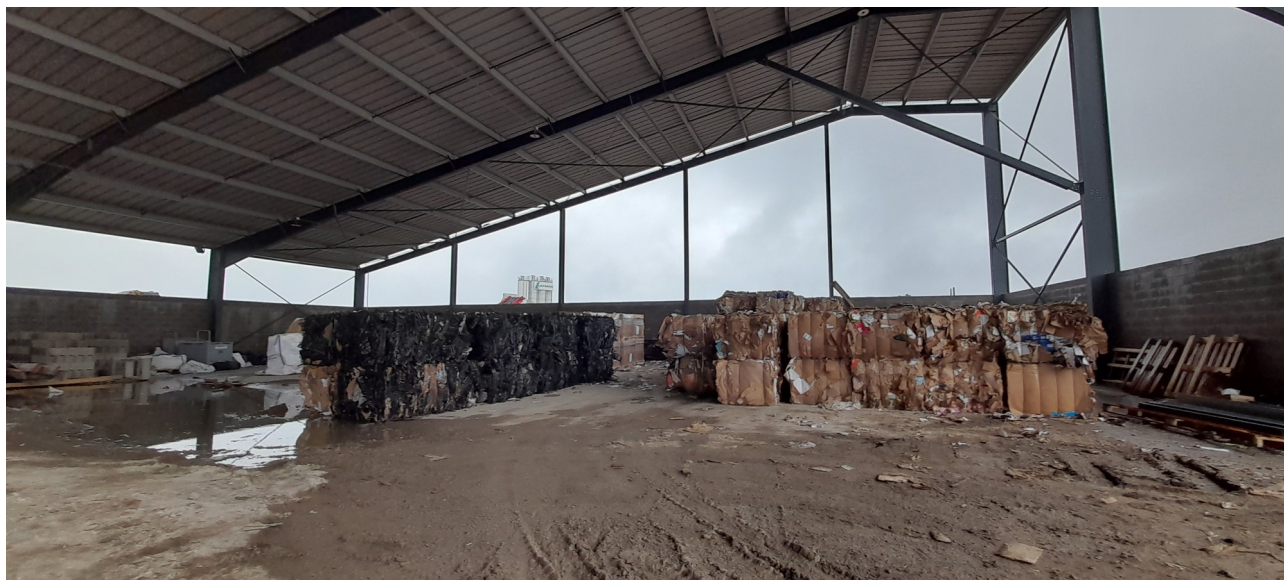
Figure 5: Nouveau bâtiment en construction, non soumis à la rubrique 1510
