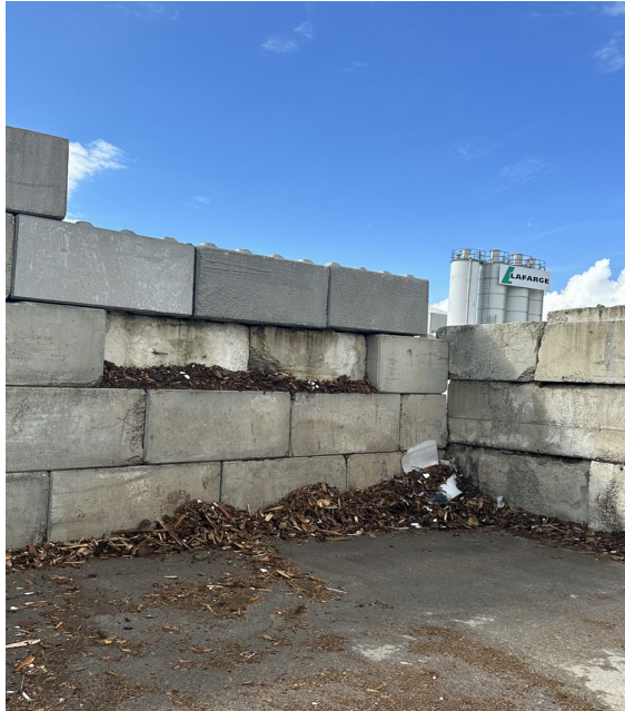
Figure 3: Blocs béton empilables de 0,8 mètre de hauteur pour 1,6 mètre de long ou de 0,6 x 2,4 mètres de long et signalétique en place permettant estimations des hauteurs et volumes des stockages présents.
