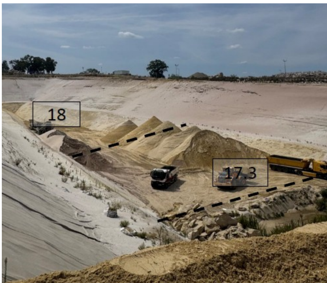
Figure 1: Evacuation des derniers tas de sablon triés réalisés semaine 30, localisation des casiers concernés, photo Tersen
