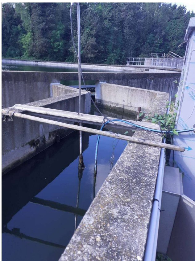
(3) Tuyau de prélèvement avec point bas Présence d'algues sur la sonde pH (jour 1)
